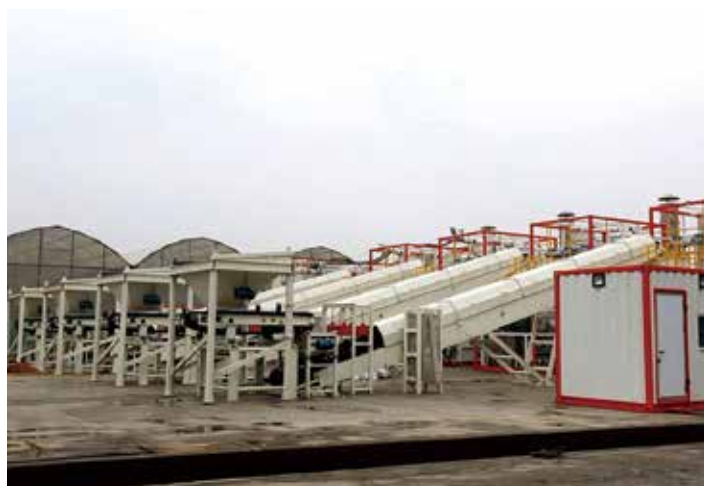
杰瑞热解吸附技术杭州作业现场
